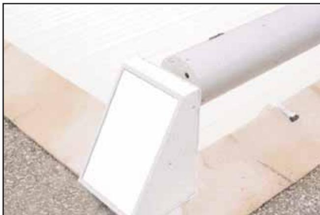
Pour terminer, remettre en place les carters sur les pieds en reposant les 4 vis TB HC M5-10.
